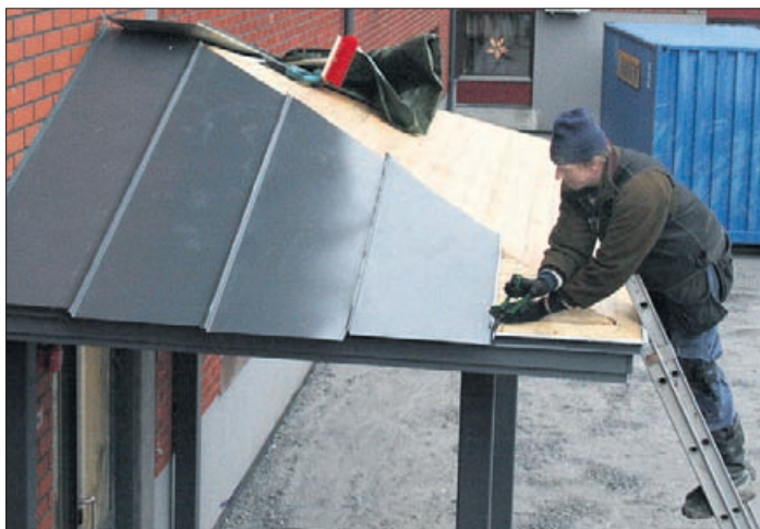
Jens Norrgård arbetar med takplåten. Norrgårds har lagt plåt både på nya Solängen och gamla hälsovårdscentralen.
