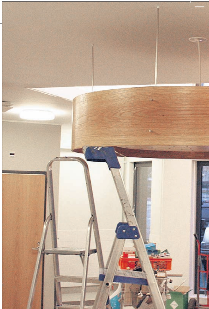
Magnus Englund installerar lampan i Solängens entréhall. Deet är Novias konststuderent.
